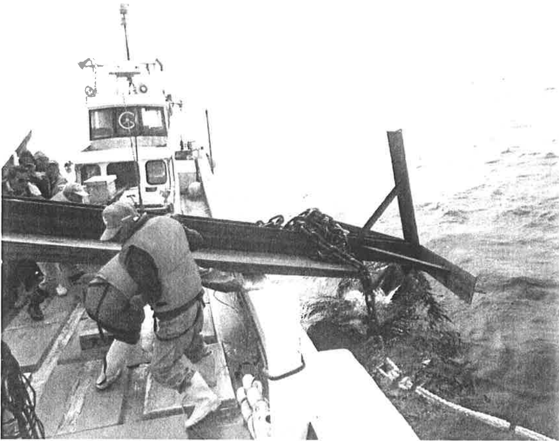
アンカー投入の様子
