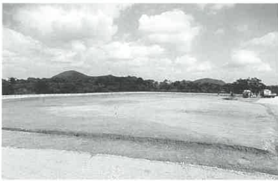
新焼却炉造成状況（福山区）
