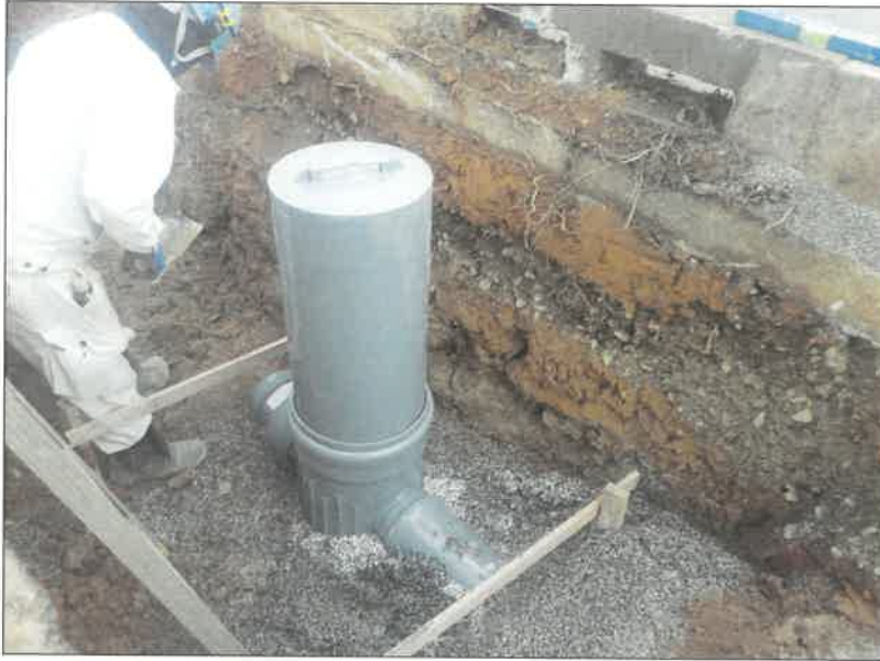
工種:人孔設置工 種別:小型マンホール工 写真タイトル: 配管状況 撮影箇所: MH#24
