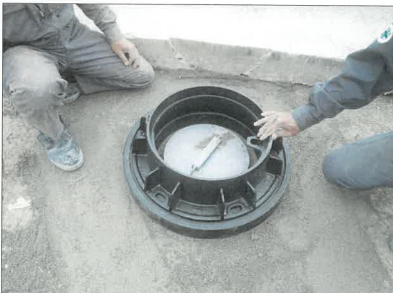
工種:人孔設置工 種別:小型マンホール工 写真タイトル: 受枠設置状況 撮影箇所: MH#12
