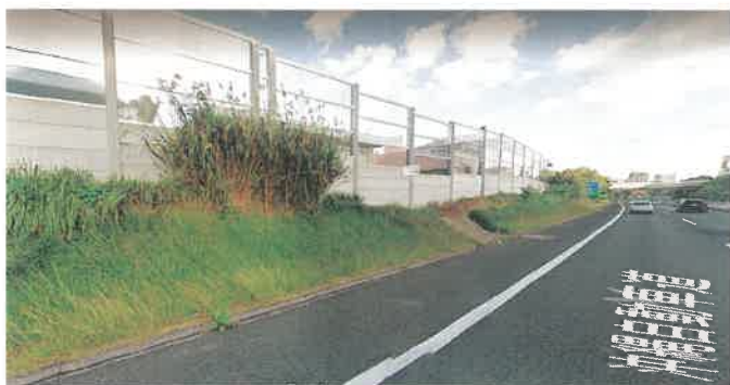
高速道路（西原町）に設置されている遮音壁
