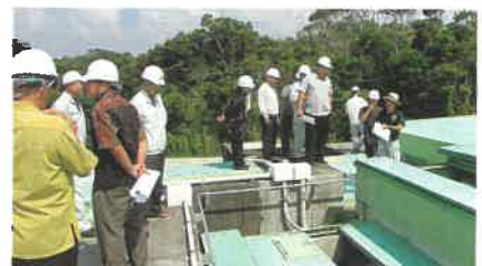
福山浄水場凝集沈澱池改修工事(その3) 工期:平成30年8月27日～平成31年3月18日
