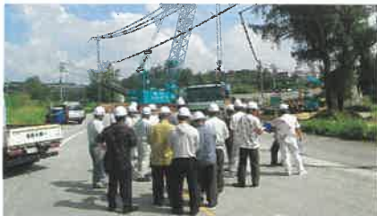
村道漢那旧国道線橋梁下部工事(1工区) 工期:平成31年1月22日～令和元年9月27日
