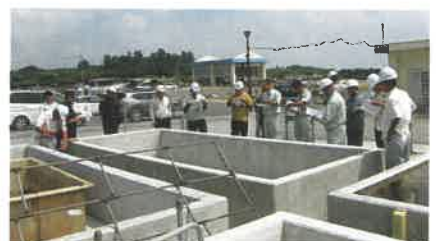
もずく種付施設建設工事 工期:平成30年8月10日～平成30年12月27日
