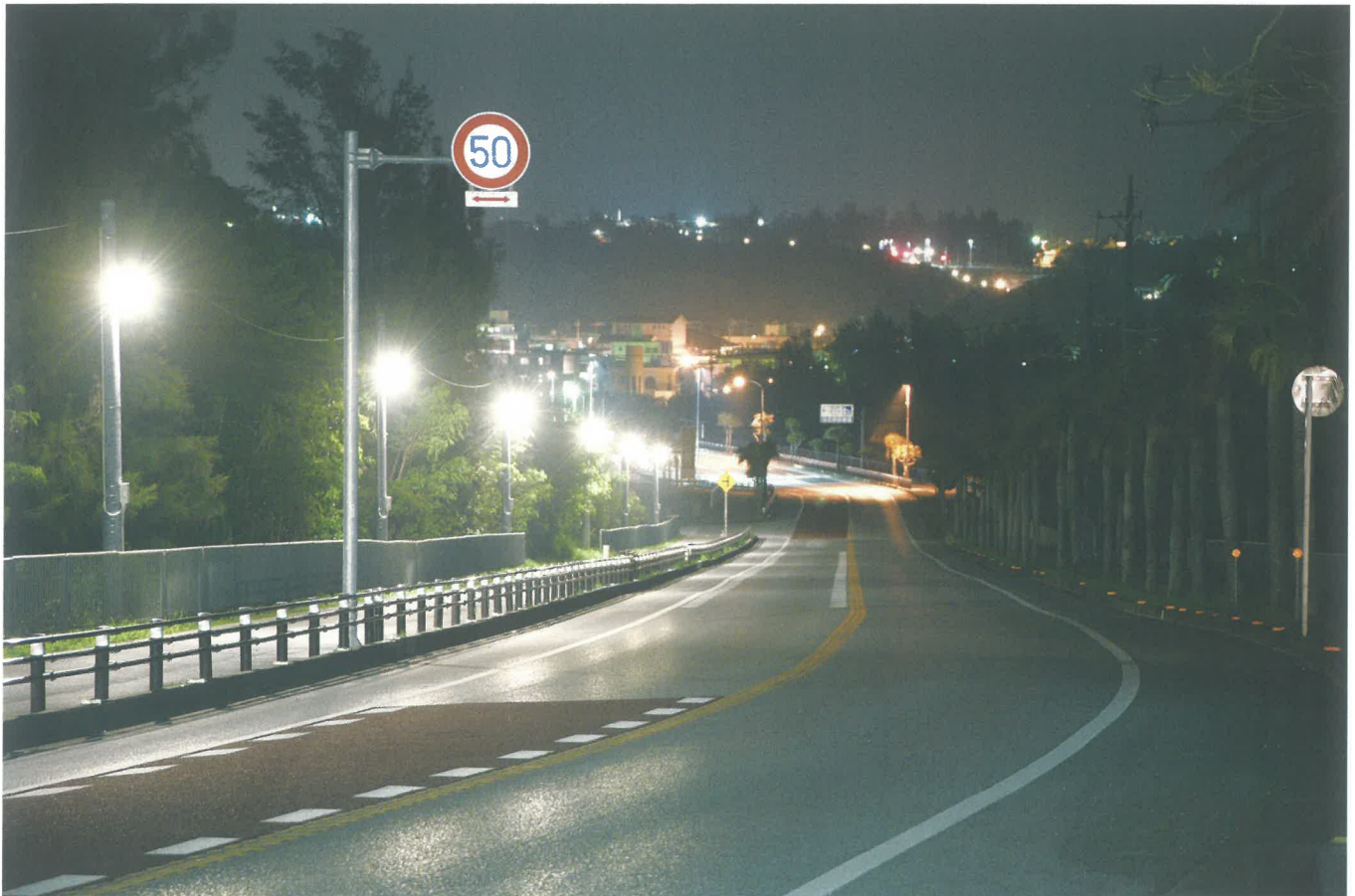
宜野座村における犯罪を抑止するとともに、村民の安心安全を確保することを目的 沖縄安全対策事業費補助金（防犯灯設置工事） 城原～漢那線
