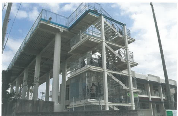
久高島 津波避難施設防災タワー
