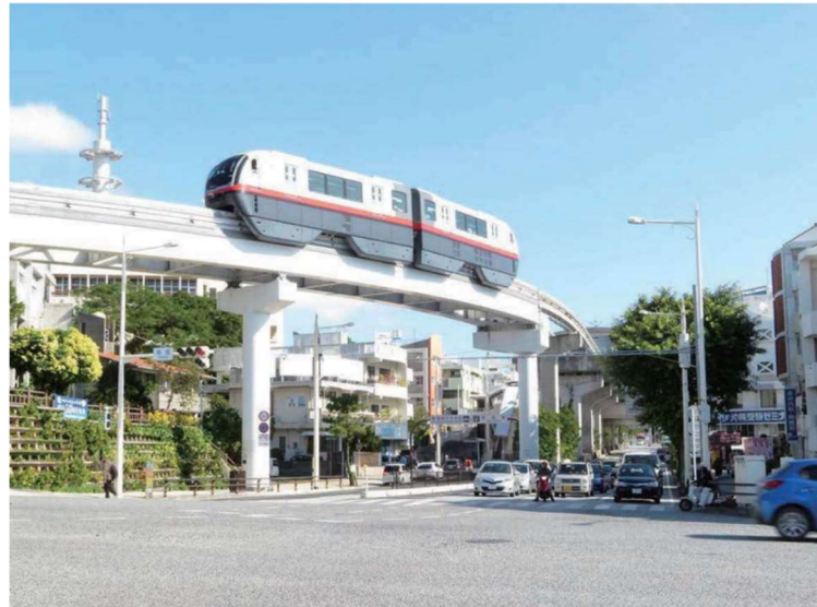
写真4 【整備後】 県道82号線・県道29号線
