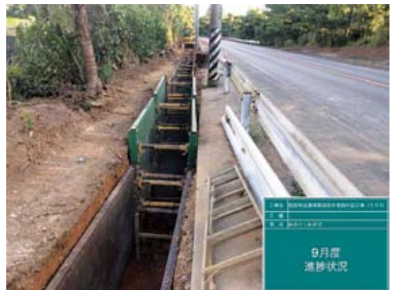
管路敷設工事
