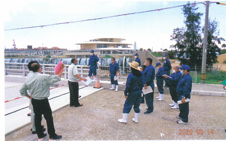
村道漢那旧国道線橋梁上部工事・下部工事(1工区・2工区)
