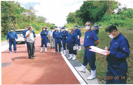
村道漢那赤平線道路改良工事(1工区・2工区)
