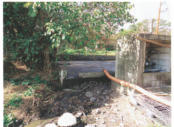
し尿層の現場の様子
