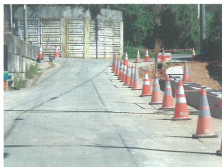
村道待口線(惣慶区)の工事の様子
