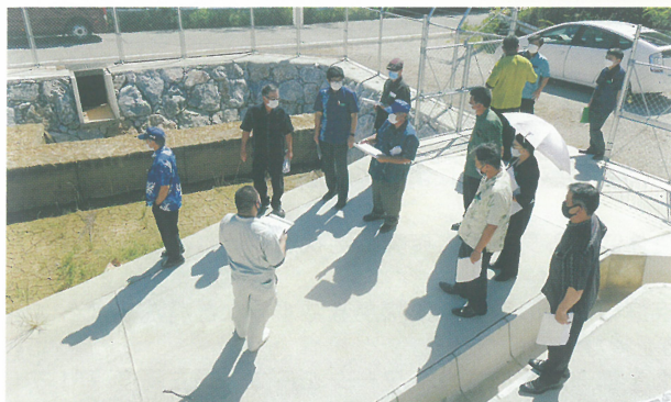
垣之外地区水質保全対策工事（3工区）
