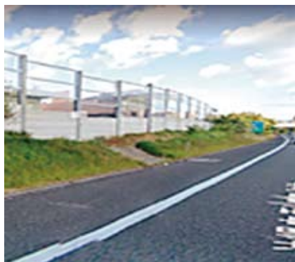
沖縄自動車道西原付近遮音壁
