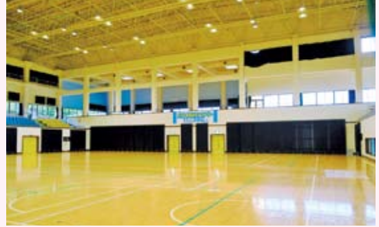
村総合体育館機能強化工事 (空調設備)
