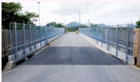
村道惣慶中央線（福地橋）補修工事
