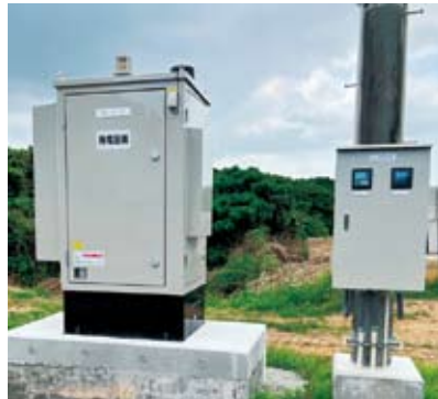
宜野座地区農業集落排水 中継ポンプ工事
