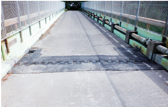
村道宜野座浄水場線（長門第二橋）補修工事（その1）
