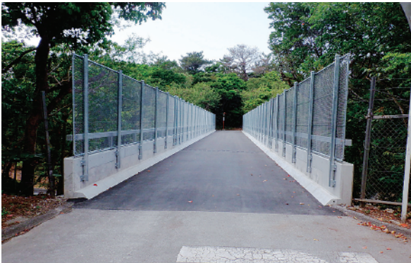
村道漢那ダム2号線（中山第二橋）補修工事
