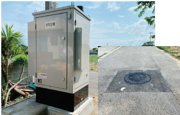
宜野座地区農業集落排水中継ポンプ更新工事（その1）
