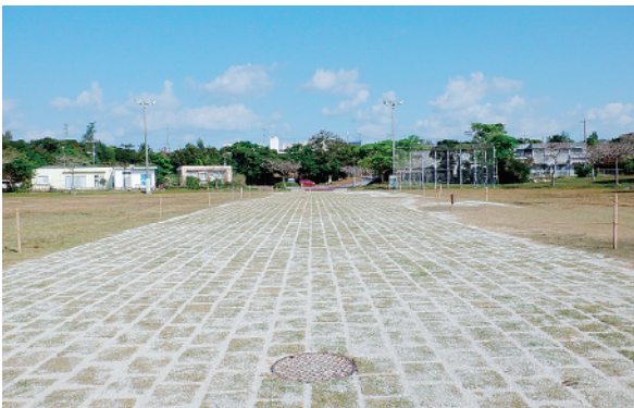
城原地区排水管布設替工事
