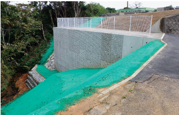
福山浄水場法面補強工事
