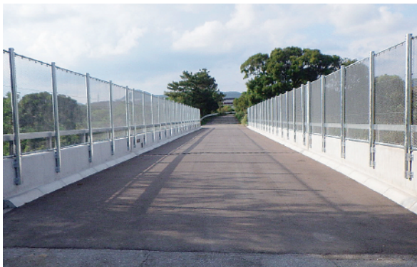
長門第一橋補修工事
