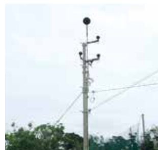
城原区民家の敷地内に設置された騒音測定器
