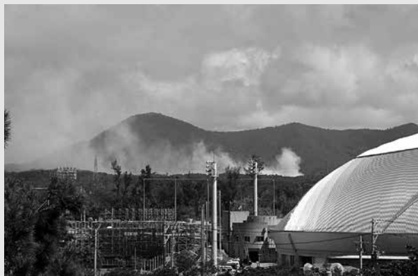
平成26（2014）年7月18日撮影、米軍ヘリから粉塵が上がっている様子。
