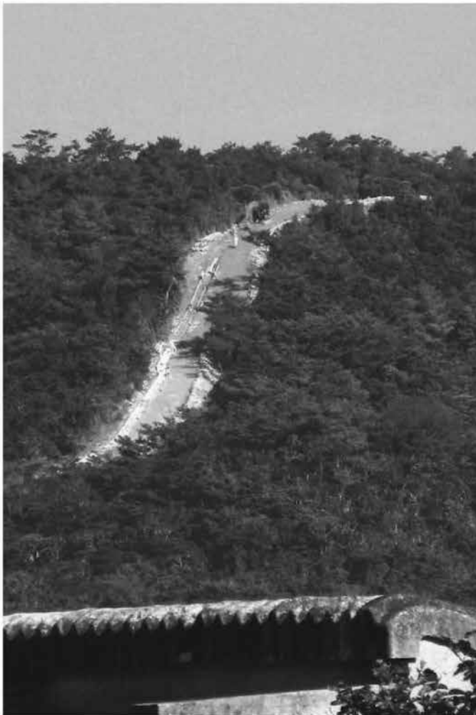
赤土がむき出しになった道路の建設現場。作業員や重機が見える＝宜野座村松田
