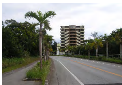
リゾートマンション（高層建築）
