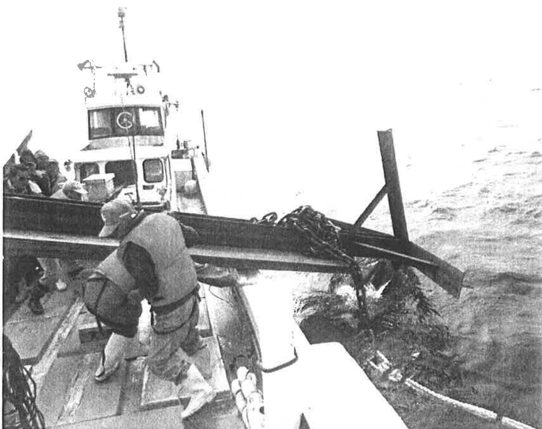
アンカー投入の様子
